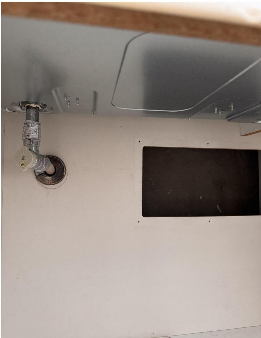
写真のポイント……ガス配管取出し部、フレキ配管状況、設置機器など
